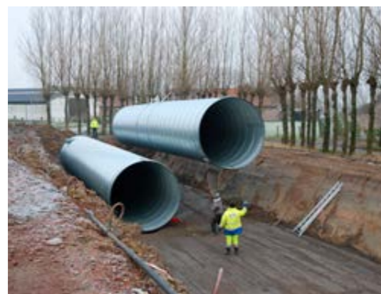
Installatie van een regenwater tank
