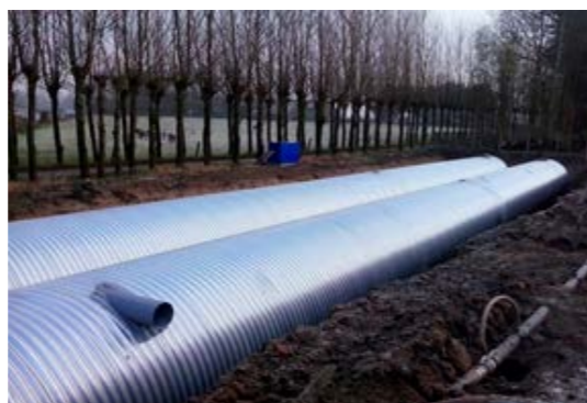
Installatie van een regenwater tank
