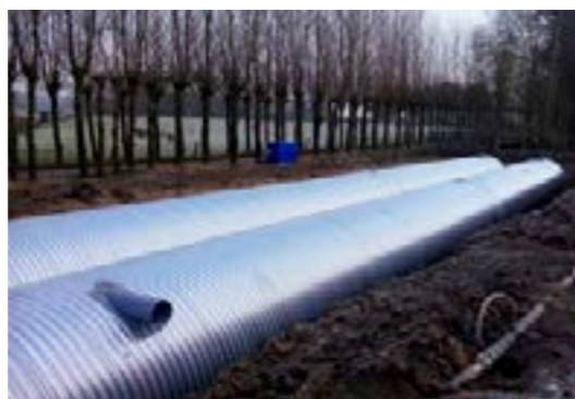
Installation d'un réservoir d'eau
