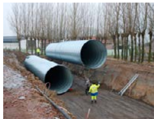
Installation d'un réservoir d'eau
