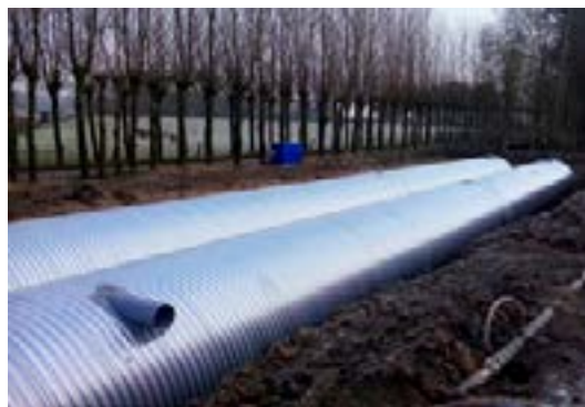
Installatie van een regenwater tank
