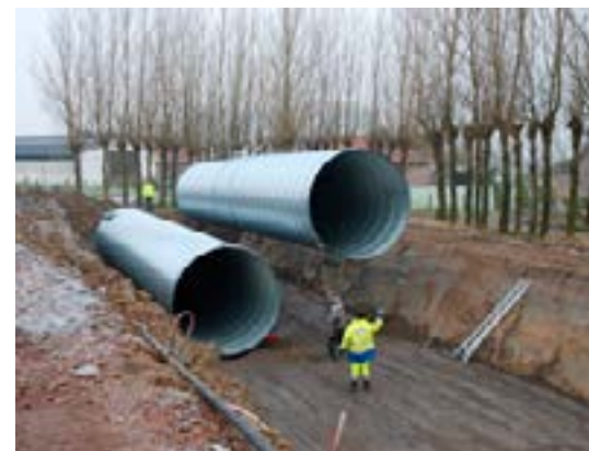
Installatie van een regenwater tank
