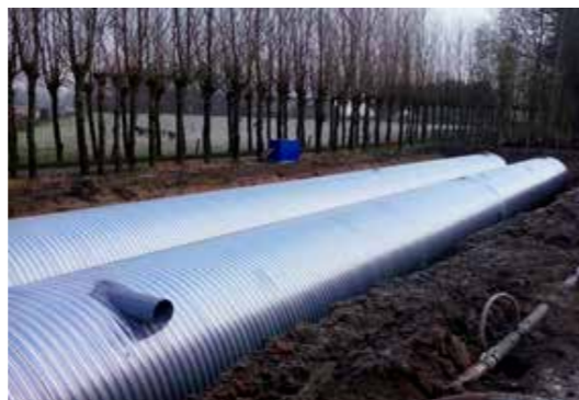
Installatie van een regenwater tank
