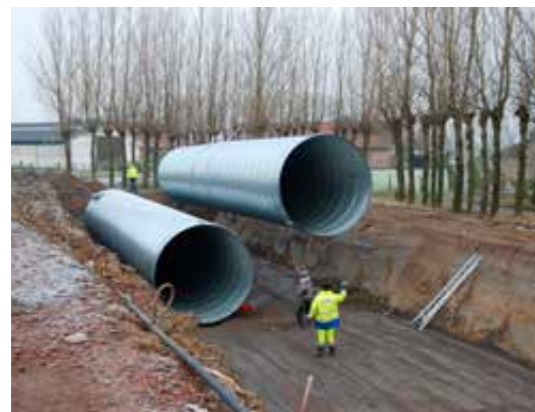
Installatie van een regenwater tank
